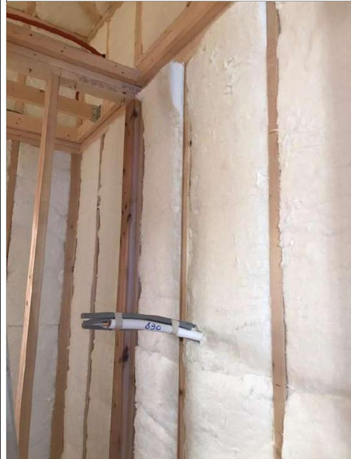
2-1口床・壁・天井（屋根）に図面通りの断熱材を使用する。(2/3)
