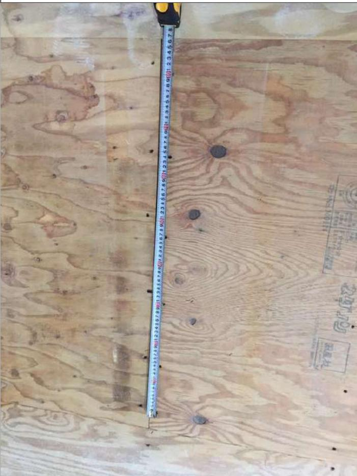
1-1口最下階の床枠組みに根太を用いない場合、床下張材は厚さ24mm又は28mmの構造用合板を用いる。(2/2)
