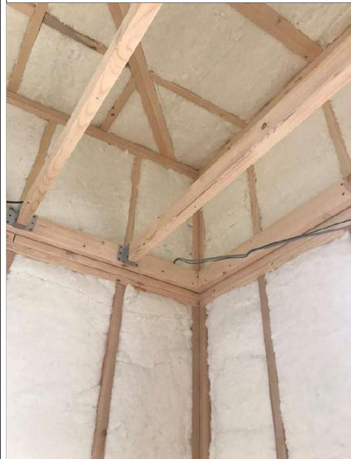
2-1口床・壁・天井（屋根）に図面通りの断熱材を使用する。(3/3)
